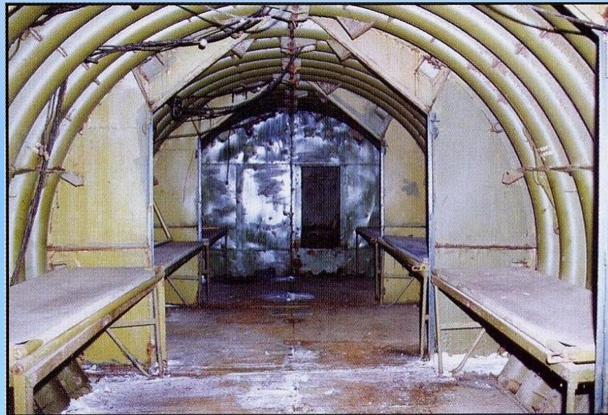
Состоит из основного помещения, двух торцевых блоков с дверными проёмами, блока входа с предтамбуром и вертикального лаза
