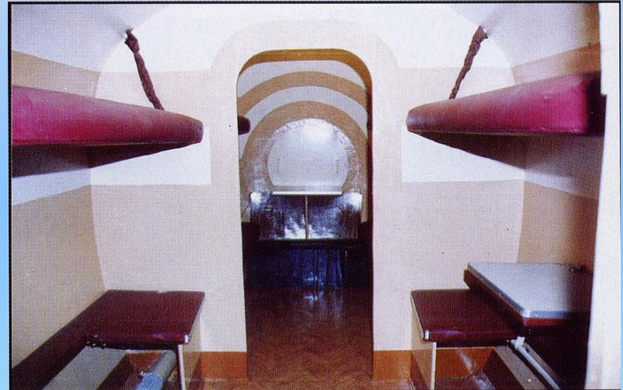
**Состав: основное помещение из 2-х отсеков, вход с двумя тамбурами, санитарно-технический отсек, сборно-разборный предтамбур, комплект средств внутреннего и бытового оборудования**
