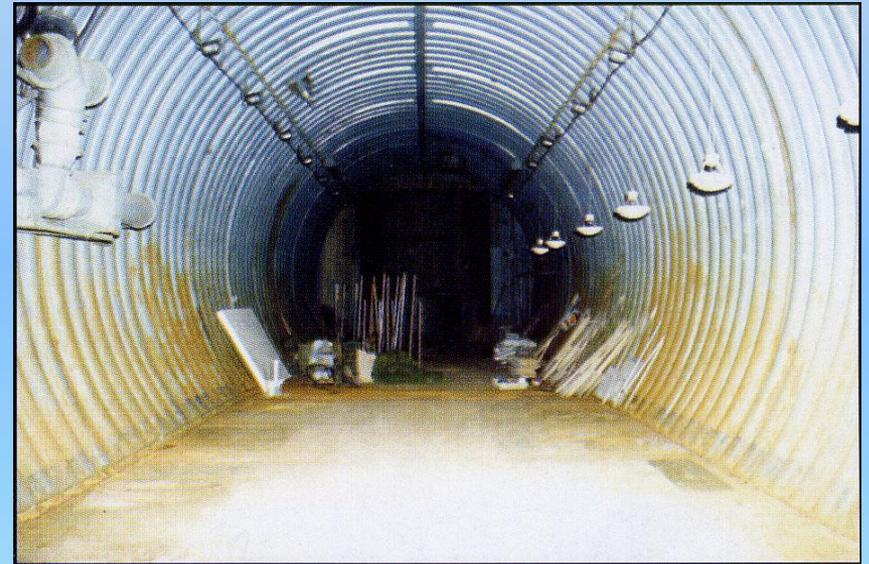
**Предназначен для защиты пунктов управления. Состоит из остова, защитных ворот и дверей, системы фильтровентиляции, отопления и освещения**
