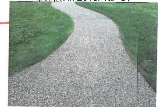
Отсыпка второстепенных аллей асфальтовой крошкой
